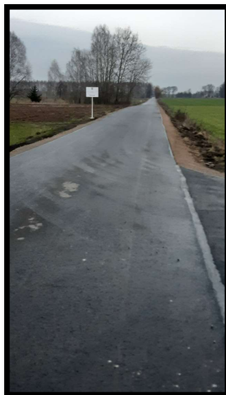
przebudowa drogi gminnej (Stara Wieś – III gościniec)
