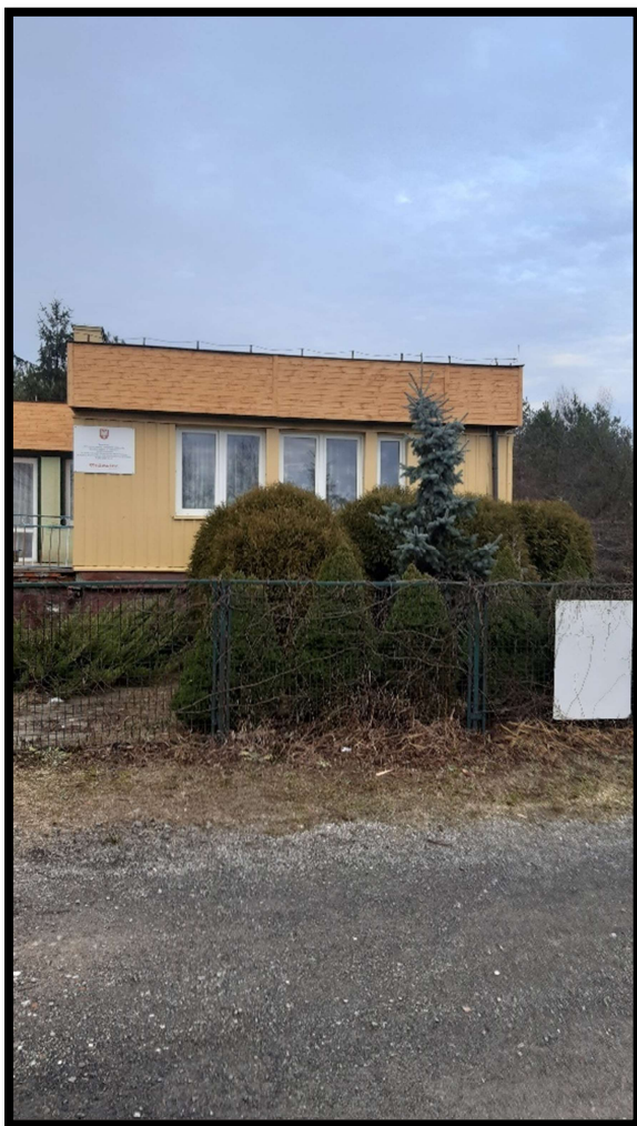
Remont elewacji frontowej świetlicy wiejskiej w Stefanowie
