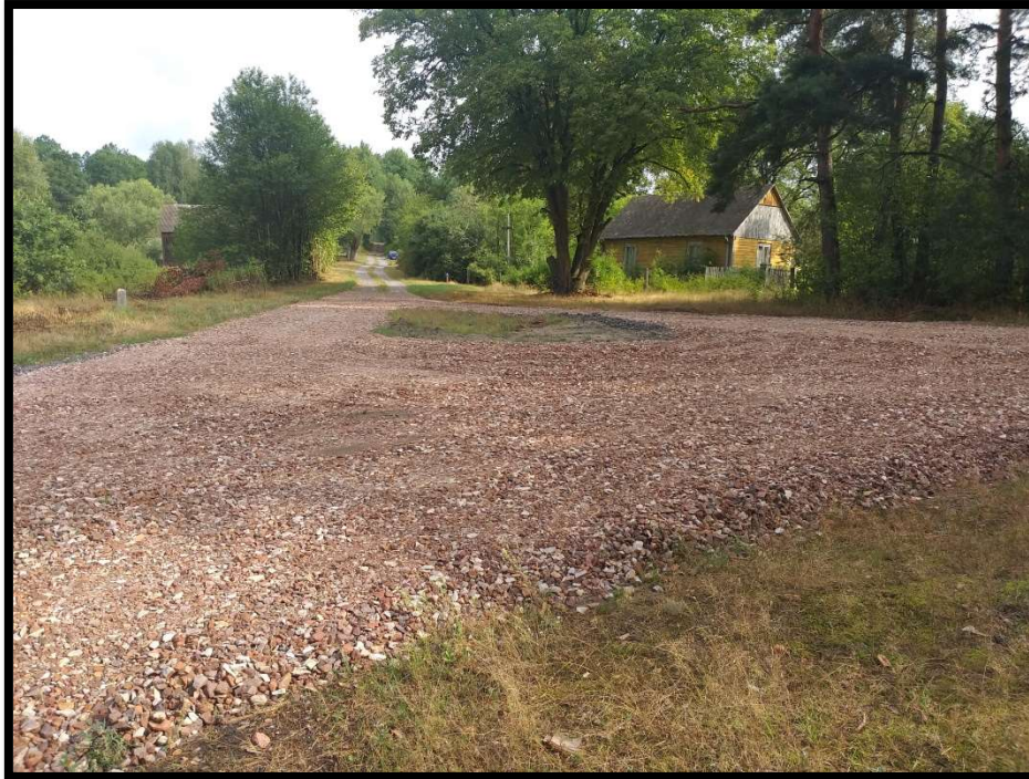
Remont dróg gminnych poprzez uzupełnienie nawierzchni kruszywem drogowym
