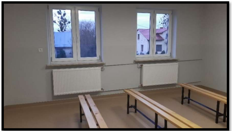
Źródło własne: Remont świetlicy wiejskiej w Łagowie
